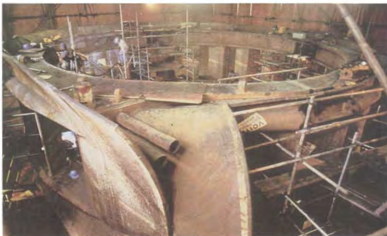
El montaje del predistribuidor en el área de montaje derecha de la casa de máquinas durante los meses de setiembre y octubre de 1980.
