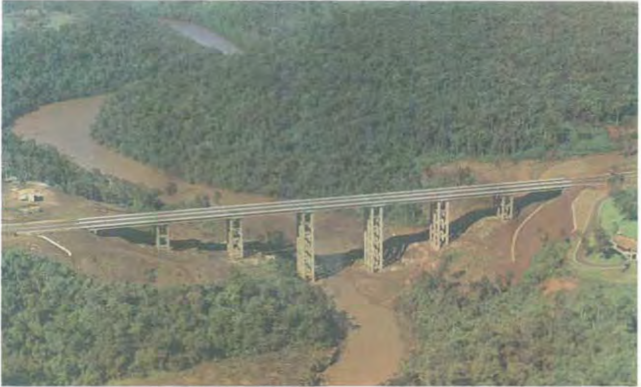
Vista del puente sobre el Río Acaray (margen derecha).
