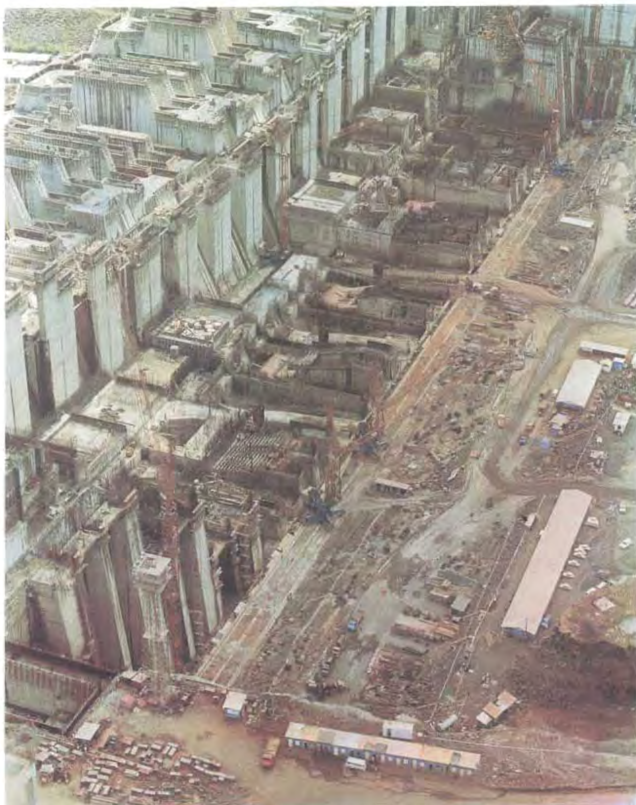
Una vista de la construcción de la casa de máquinas en el lecho del Río Paraná.
