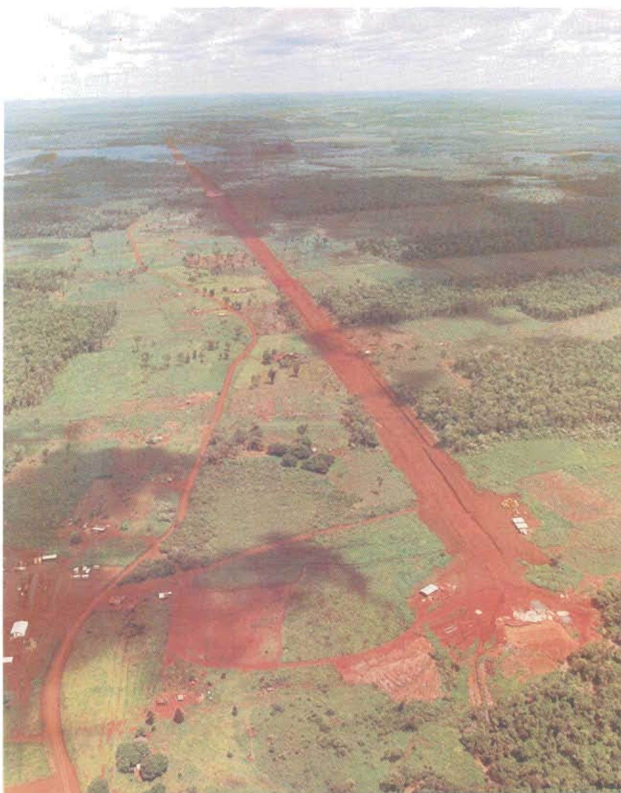
Vista del estado en que se encontraba, al término del ejercicio de 1980, la construcción de la vía de acceso a Puerto Adela (margen derecha).
