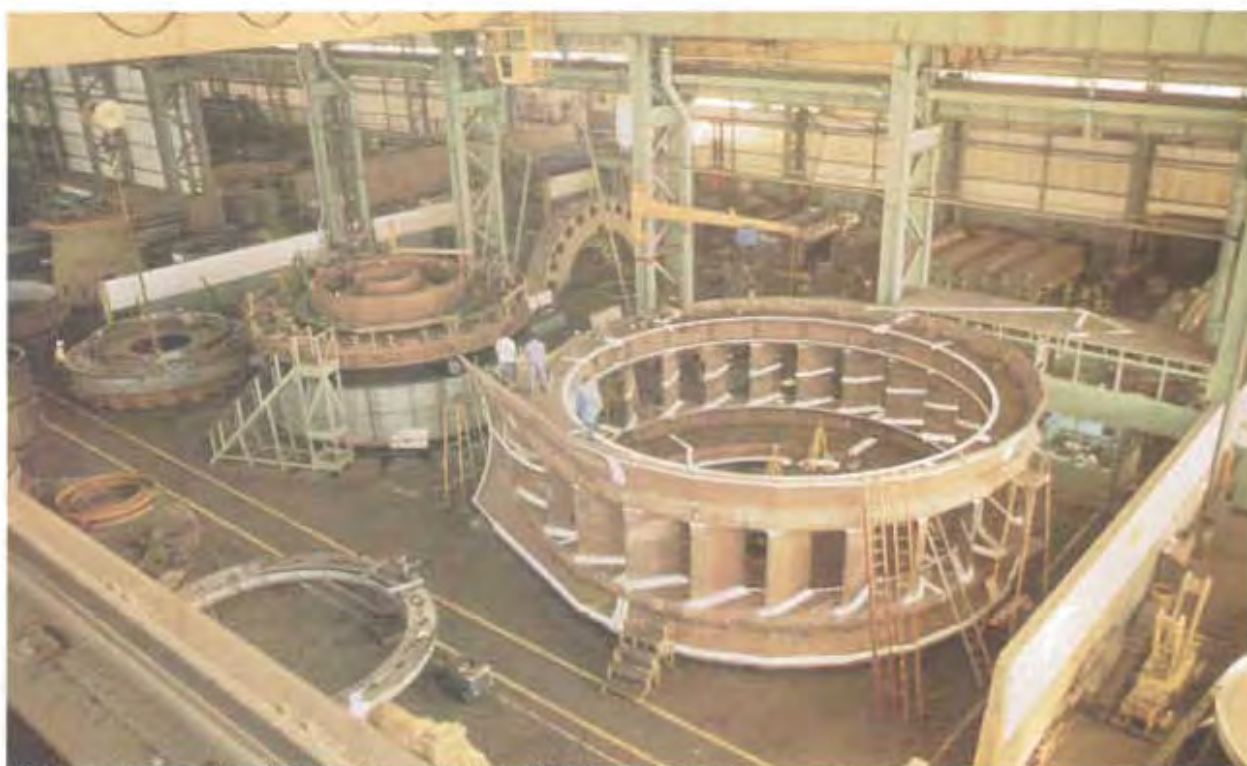
El premontaje del predistribuidor en las instalaciones de la fábrica, a mediados de 1980.
