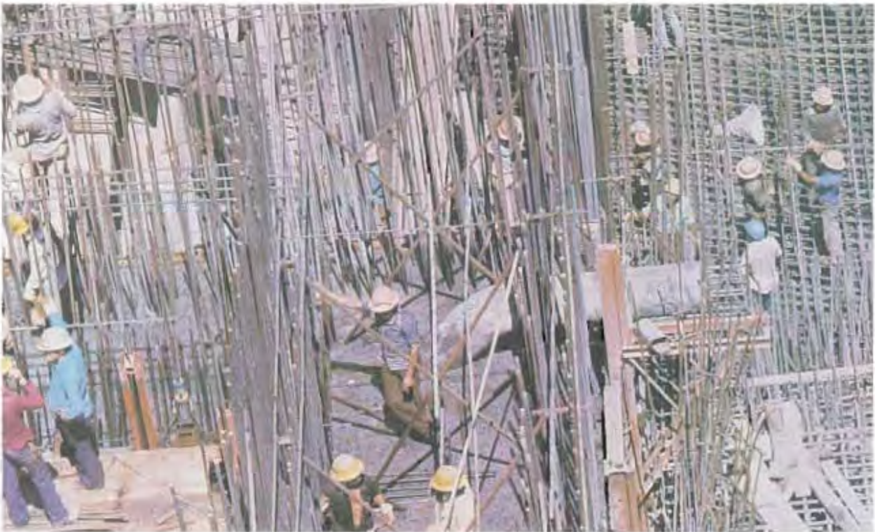
Cuatro instantáneas que indican la compleja trama de acero estructural en la casa de máquinas.
