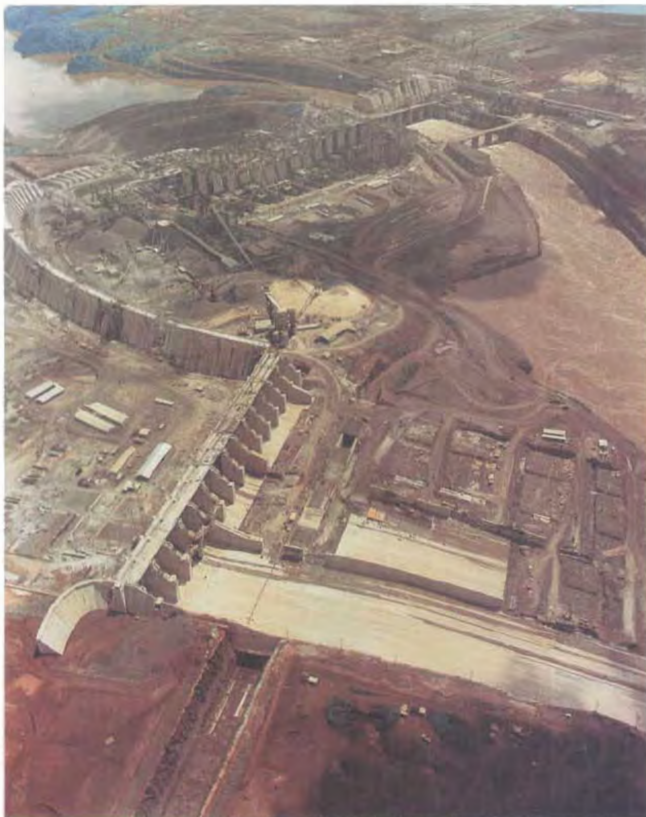
Vista aérea general de la obra donde se aprecia en primer plano el vertedero y a continuación la presa lateral derecha, la presa principal, estructura del control de desvío y la transición entre la presa principal y la presa de enrocado.
