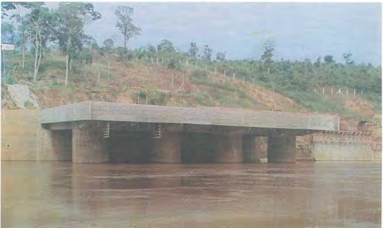
Dos instantáneas del estado en que se encontraba, al término del ejercicio de 1980, la construcción del atracadero en el Río Paraná, margen derecha, en Puerto Presidente Franco.
